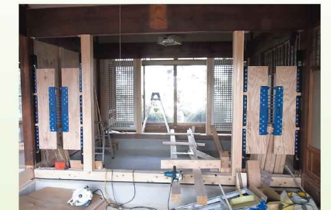
住宅耐震改修工事事例
