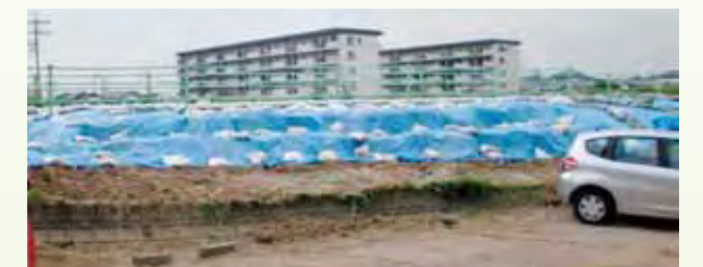
八田川堤防法面崩壊
