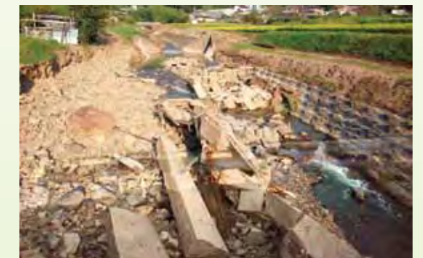
内津川の護岸崩壊
