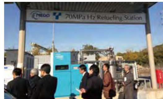
水素ステーション
