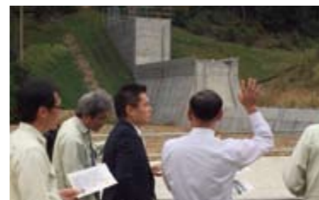
春日井市高座町 砂防堰堤工事現場
