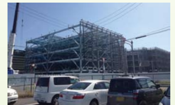
県営名古屋空港の駐車場整備工事
