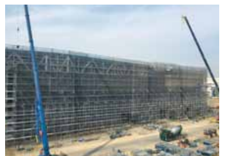
建設中のMRJ生産工場
