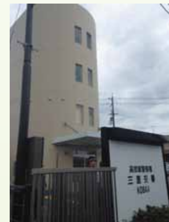
津波避難ビルとして設置された 高知東警察署三里交番
