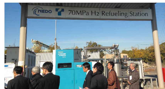
水素ステーション
