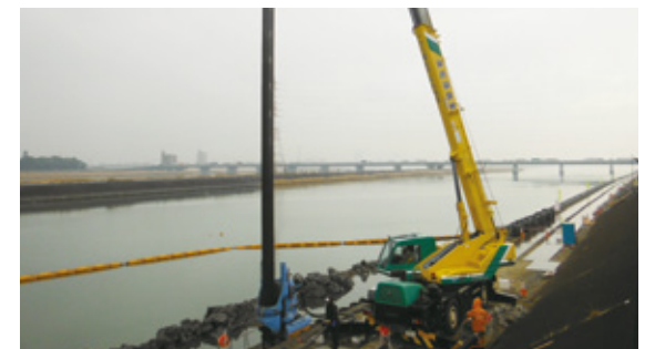
堤防工事(新川)
