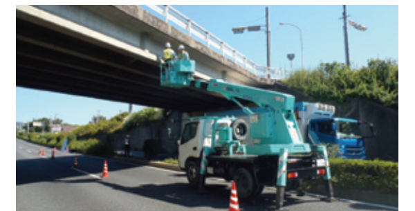
春日井市内明知跨道橋の点検・補修作業
