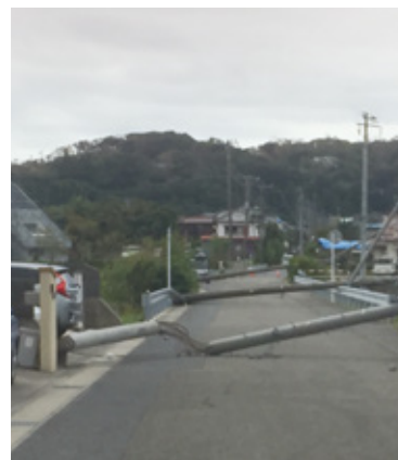
台風15号による被災現場
