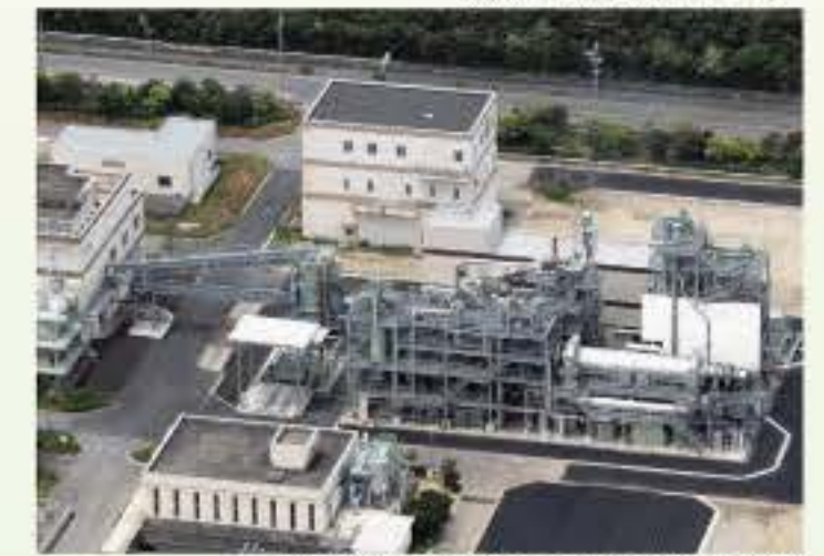
衣浦東部浄化センター下水汚泥燃料化施設
